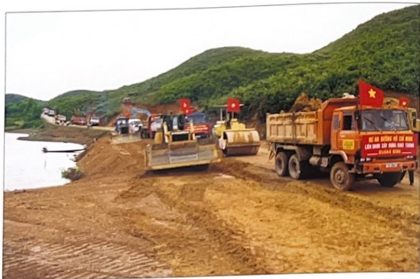
L ực lượng cơ giới san ủi mặt bằng xây dựng đường Hồ Chí Minh đoạn Nam Xuân Sơn - Bắc Đà Mài (Bố Trạch - Quảng Bình) (2000). M otorized vehicles levelling ground for construction of Ho Chi Minh Highway, South Xuan Son - North Da Mai section (Bo Trach - Quang Binh) (2000).
