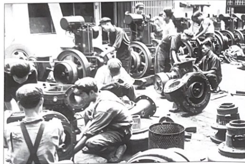
S ản phẩm máy bơm nước của Nhà máy cơ khí Duyên Hải (Hải Phòng) đang lắp ráp. Water pumps being turned out and assembled by Duyên Hai mechanical engineering plant (Hai Phong).
