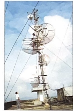
L ắp đặt ăng-ten vi ba tại Thành phố Vinh (Nghệ An). I nstallation of ground-satellite antenna in Vinh City (Nghệ An).
